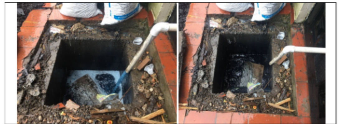
Foto No. 5 y 6. Vertimiento de ARnD caja externa.
